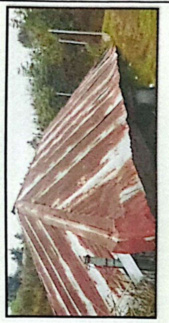
Foto 4: lamina oxidada
